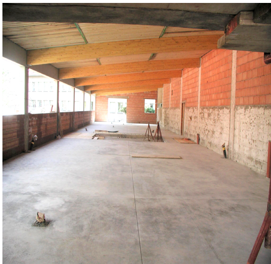
Bild 8: Baufortschritt des Anbaus im Dezember 2004
