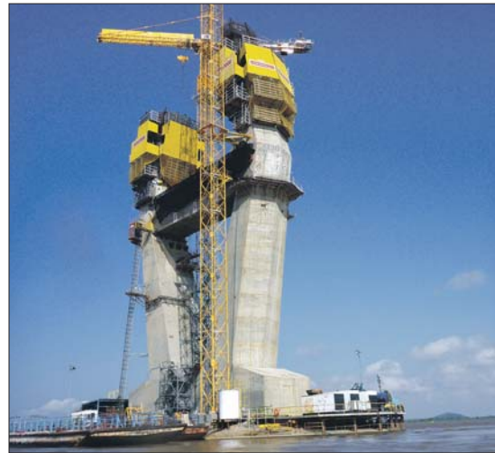
Die mehr als elf Kilometer lange Brücke über den Orinoco River soll 2015 fertiggestellt werden. Doka Selbstklettersysteme bringen die Pylone in Form. Foto: zVg
