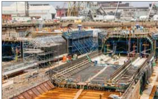
Insgesamt elf Tunnelsegmente mit je 106 m Länge werden im Trockendock in Baltimore mit Doka-Schalung betoniert
