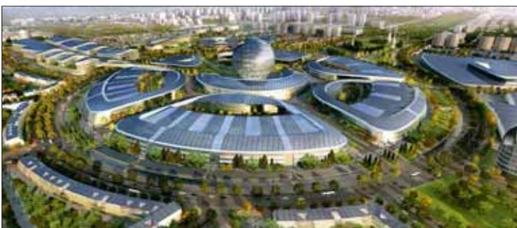
Für das Dach des kugelförmigen Gebäudes stellt Ertex Solar 380 individuell angefertigte Elemente her, die vor Ort nur noch montiert werden müssen.
