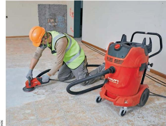
Schleifgerät mit Absaugung.
