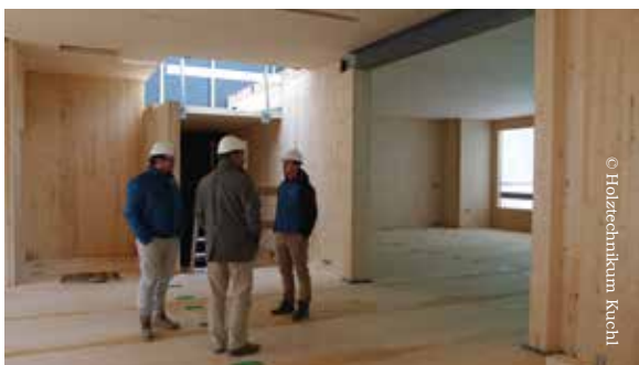
HTK-Baustelle: Baustellenaufnahme am Holztechnikum Kuchl
