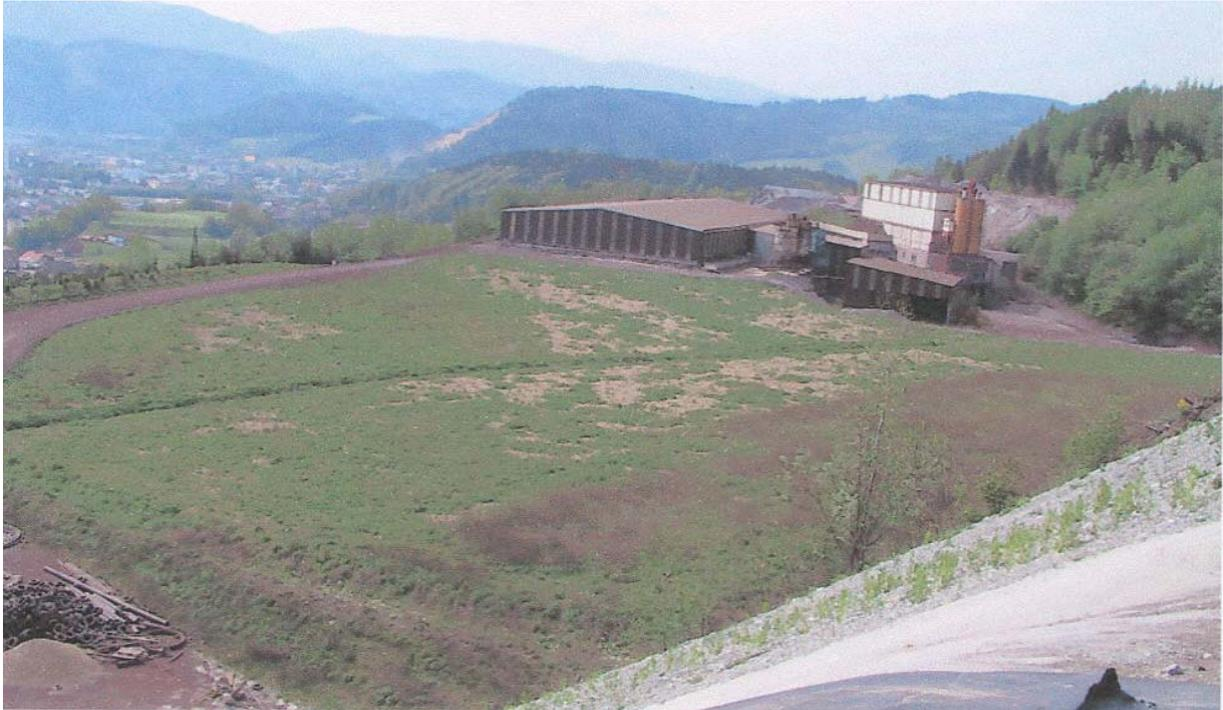
Abbildung 4: Abgedeckter rekultivierter Bereich Silbergrabenhalde
