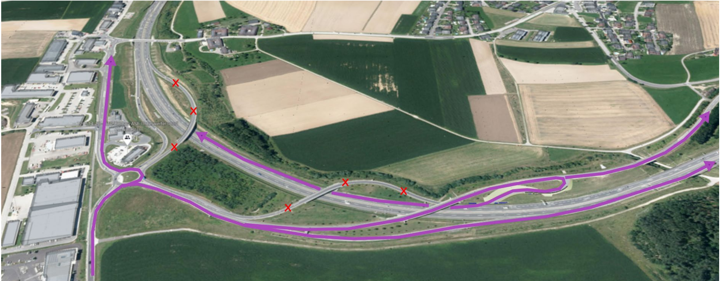
B124/B125 Umbau ASt. Unterweisersdorf
