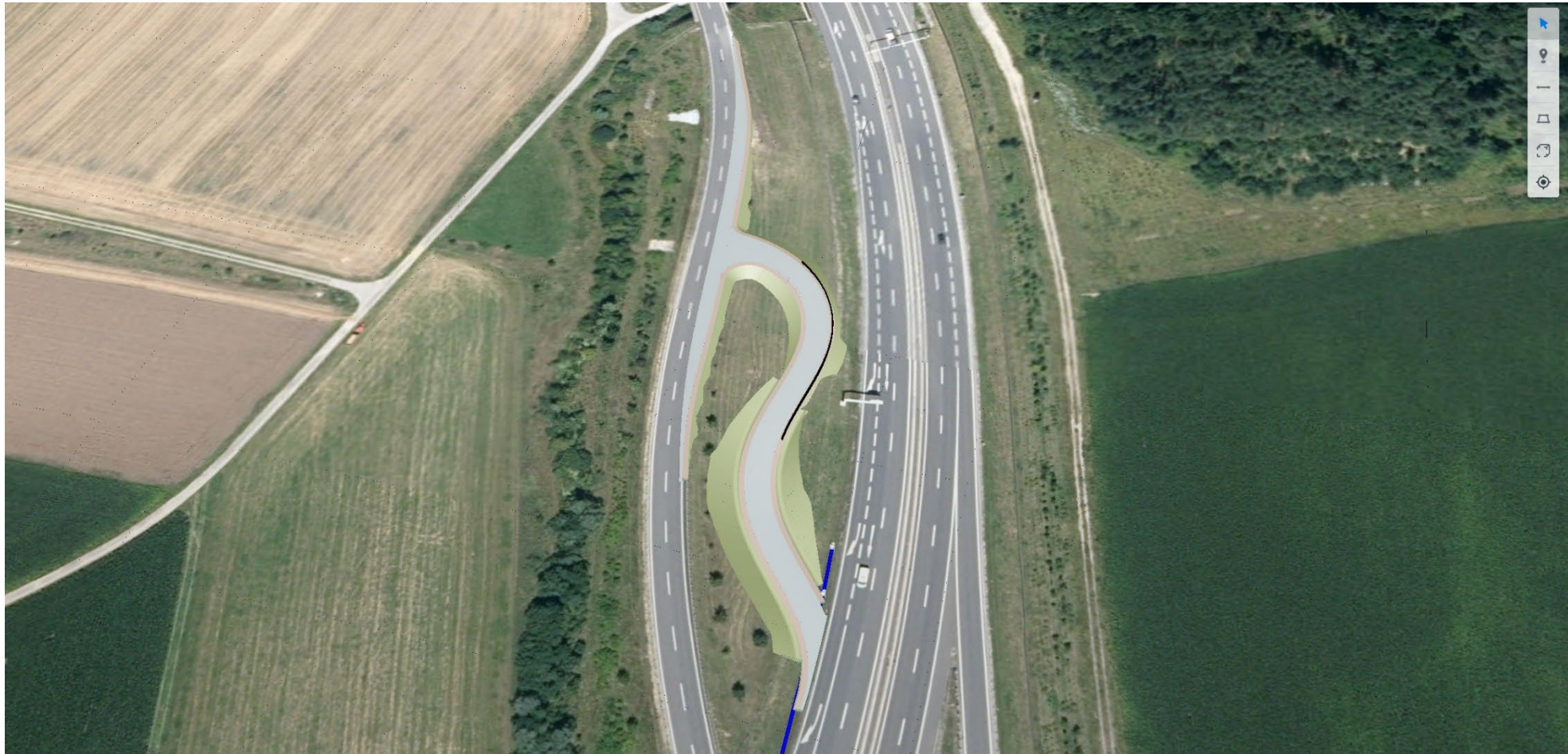
B124/B125 Umbau ASt. Unterweikersdorf
