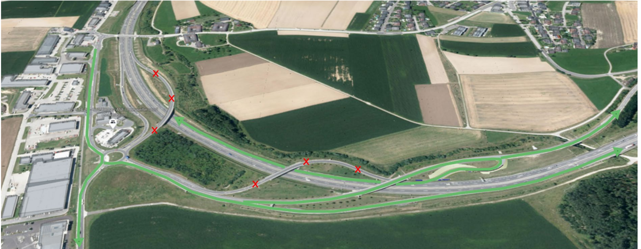
B124/B125 Umbau ASt. Unterweisersdorf
