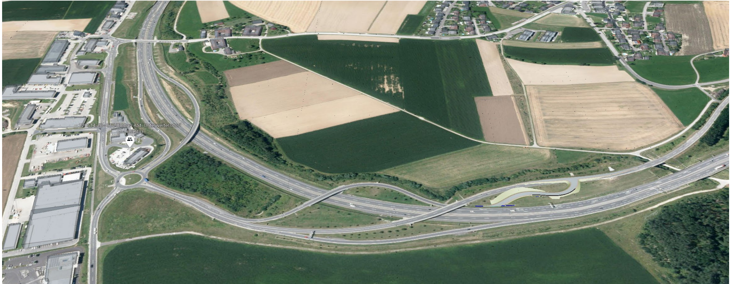
B124/B125 Umbau ASt. Unterweisersdorf
