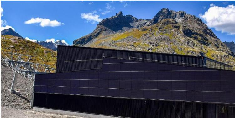
Die Gebäudehülle wurde mit einer PV-Anlage ausgestattet, die rund **40% des Energiebedarfs** der Bahn abdecken kann.
