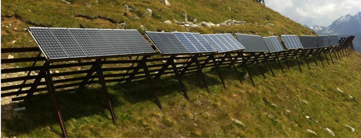
Photovoltaikanlage Lawinengebäude Bellwald<sup>138</sup>
