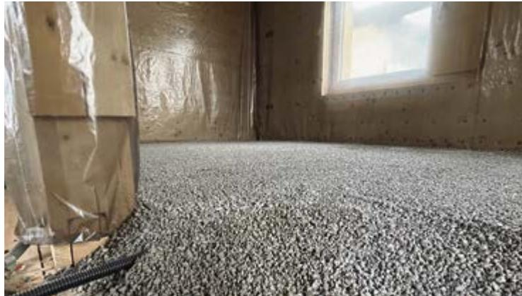
Das Bindemittel „Elastogrit“ bleibt nach dem Einbringen elastisch.
