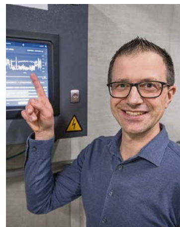
Facility Manager Daniel Mayr vor der Steuerung des Druckluftkompressors. © W&H
